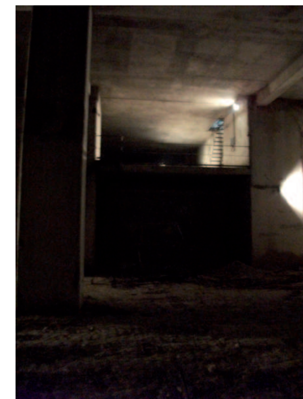
Amorce des réservations vers la salle d'échange existante (photo EPADESA)
