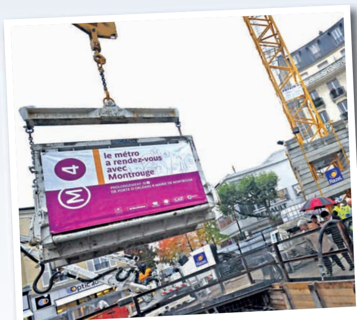
Ligne 4 : un des nombreux chantiers de prolongement qui avance...
