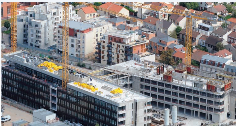
Une ville en développement : logements et immeubles d'activités en construction
