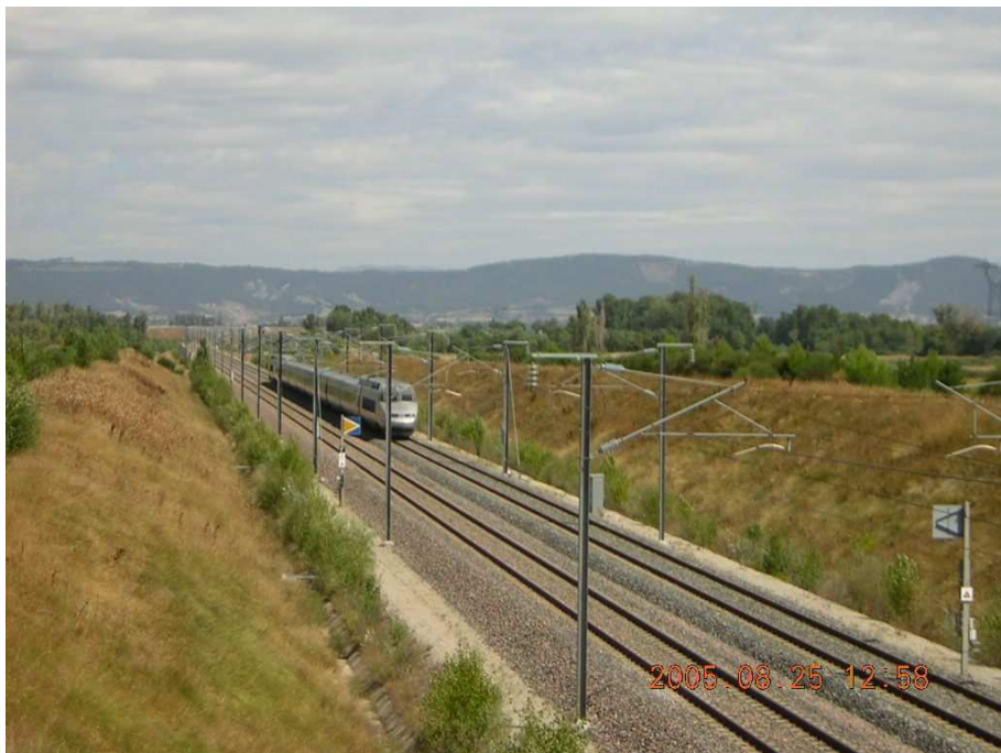
Merlons de terres.
