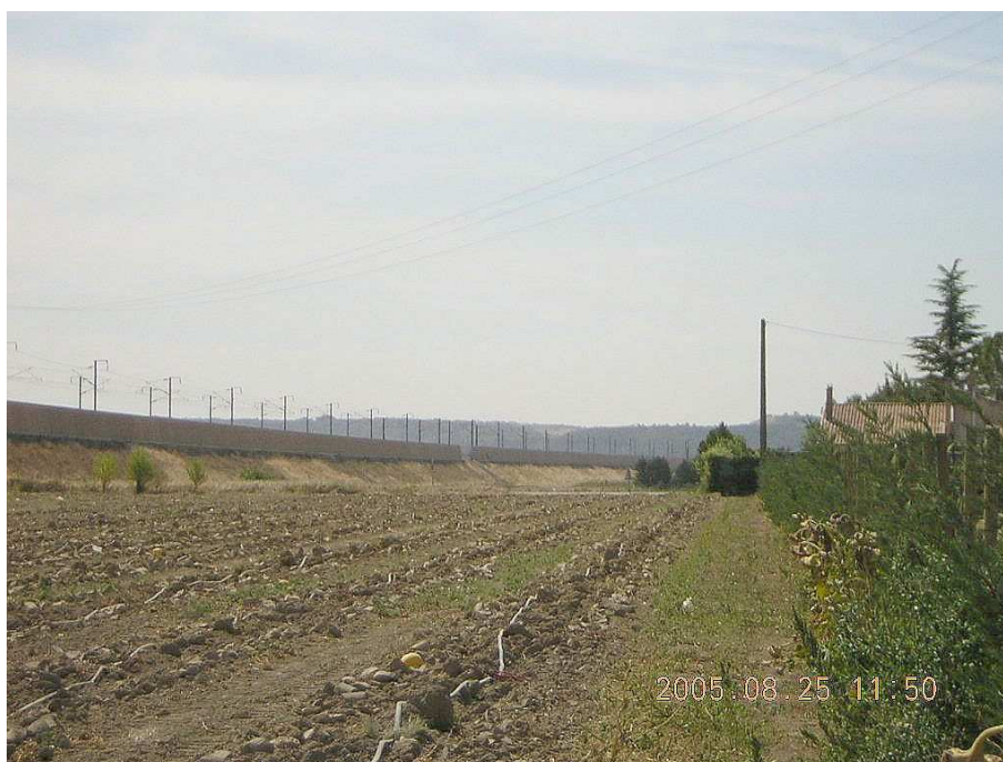
Un long mur antibruit mais peu esthétique en face de maisons .
