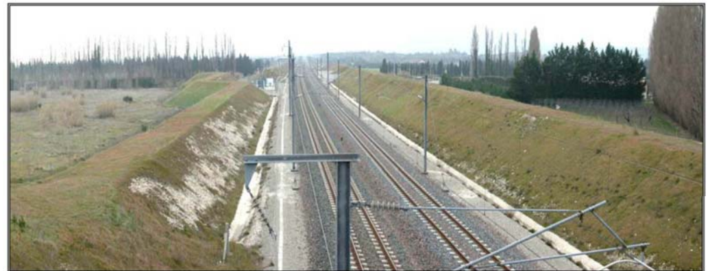
Merlon le long de la LGV Méditerranée
