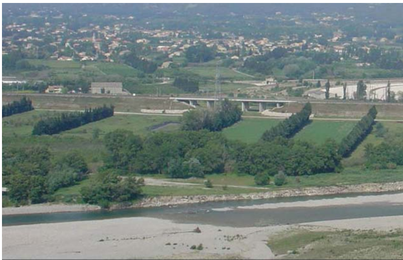
Ouvrage de décharge sur la LGV Méditerranée
