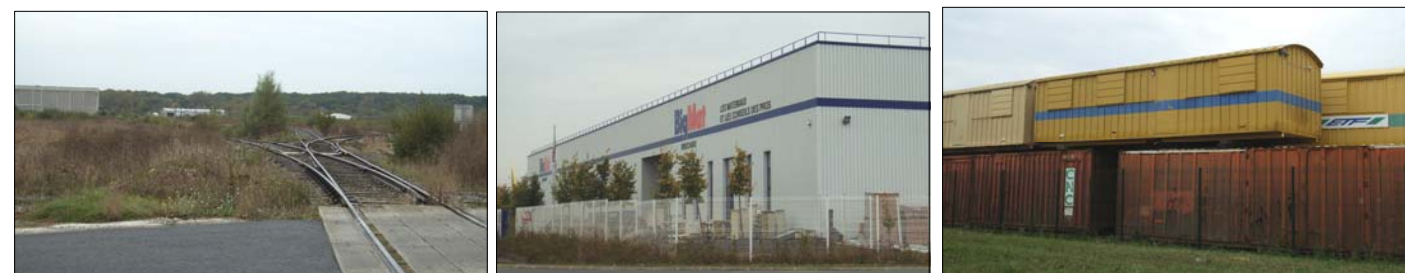
Figures 48, 49 et 50 : plateforme Centre Berry Logistique : embranchement fer, entrepôt, conteneurs du port sec (photos : Setec Organisation).
