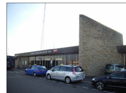
Figure 14: gare de Mâcon-Loché TGV (photo : Setec Organisation).
