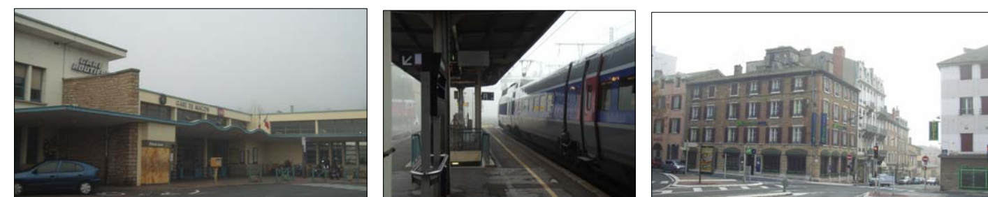
Figures 10, 11 et 12: gare de Mâcon-Ville, TGV en gare de Mâcon-Ville, place de la Barre (photos : Setec Organisation).
