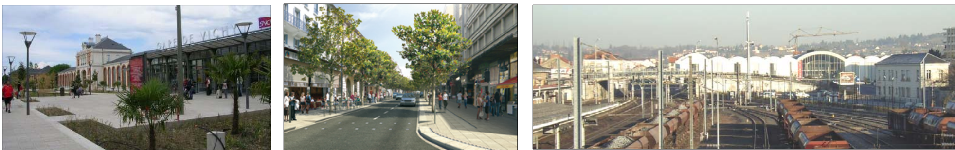
Figures 45, 46 et 47 : gare de Vichy rénovée, projet de réaménagement de la rue de Paris, l'Atrium en bordure du faisceau ferroviaire (photos et schéma : SNCF, Ville de Vichy, Setec Organisation).
