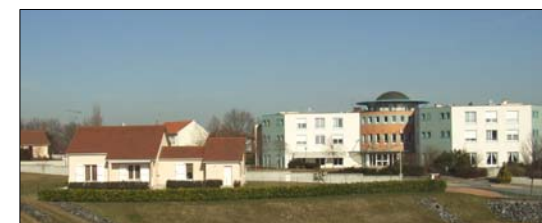
Figure 43 : Bellerive-sur-Allier : centre-ville - médiathèque (photo : Setec Organisation).
