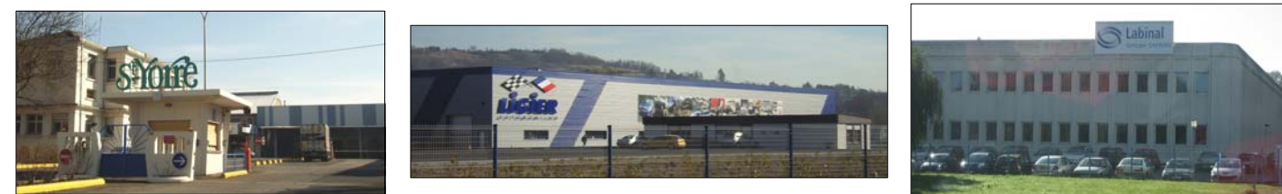
Figures 32, 33 et 34 : usine d'embouteillage à Saint-Yorre, usine Ligier à Abrest, usine Labinal à Charmeil (photos : Setec Organisation).
