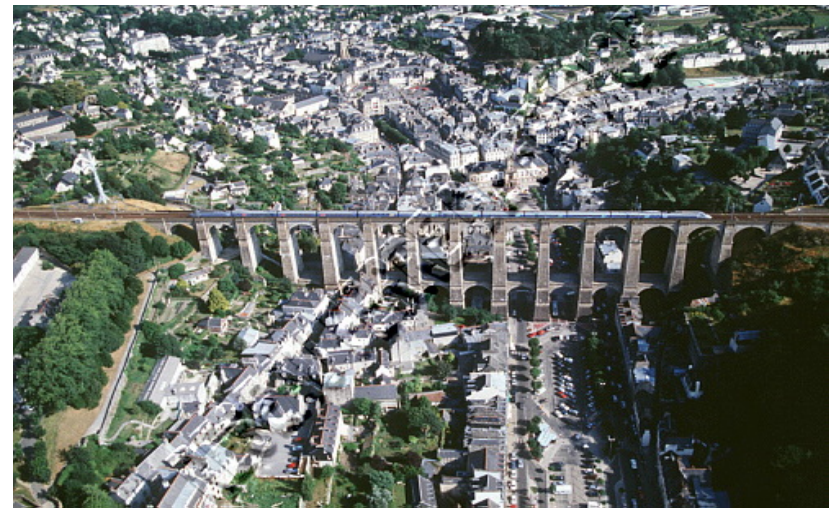
Viaduc de Morlaix
