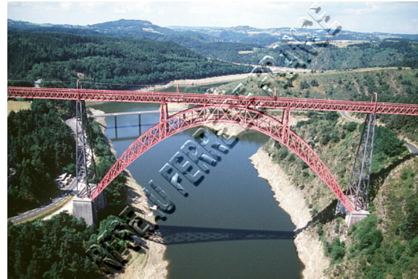
Viaduc de Garabit (gorges de la Truyère (Cantal))
