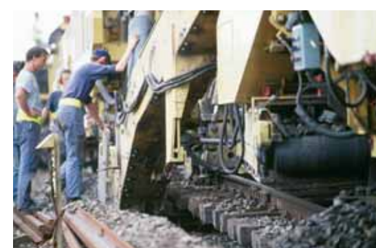
Remplacement de ballast.
