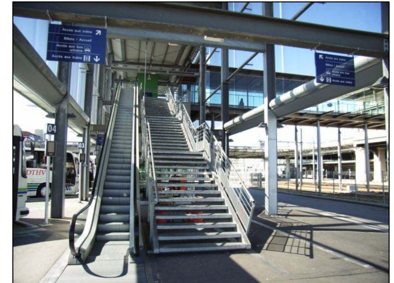
Les escaliers d'accès à la gare ferroviaire.
