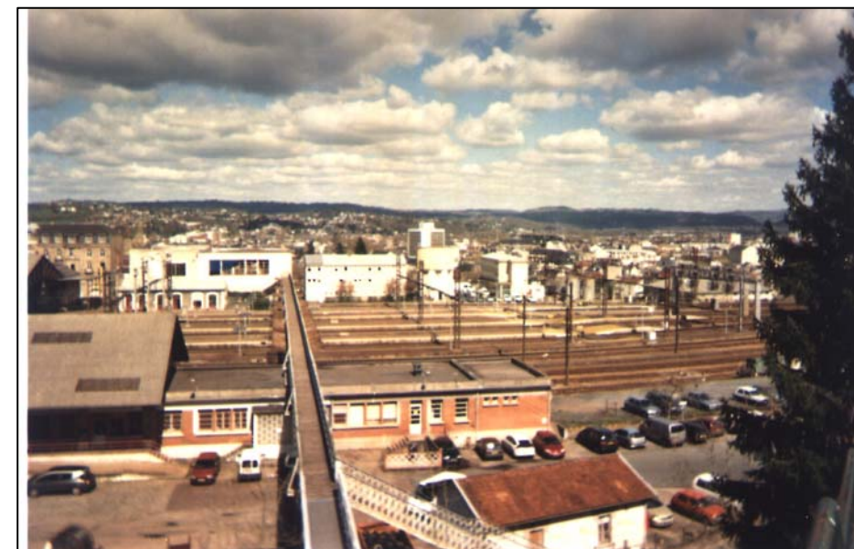
La coupure urbaine du faisceau de voie avec la passerelle piétonne
