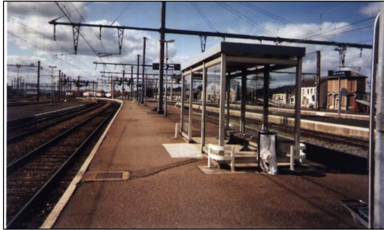
Les extrémités découvertes (Ouest) des quais avec abris voyageurs.
