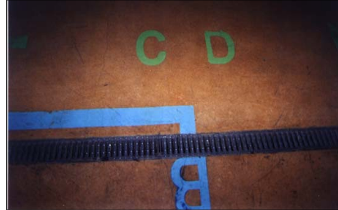
Marquage au sol des différentes voies dans le passage souterrain.
