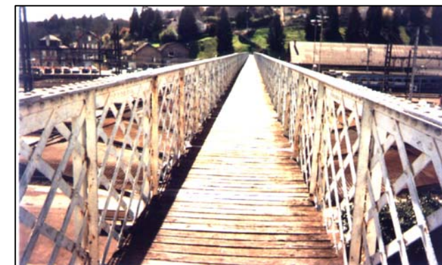
La passerelle piétonne enjambant le faisceau de voies.
