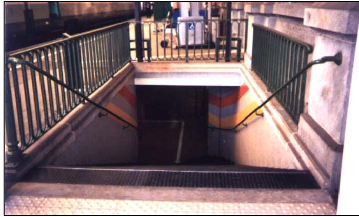
Escalier d'accès aux quais depuis le quai 1
