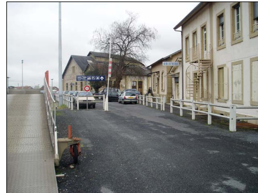
Bâtiments du CE (bibliothèque), de la SUGE et bâtiments sociaux
