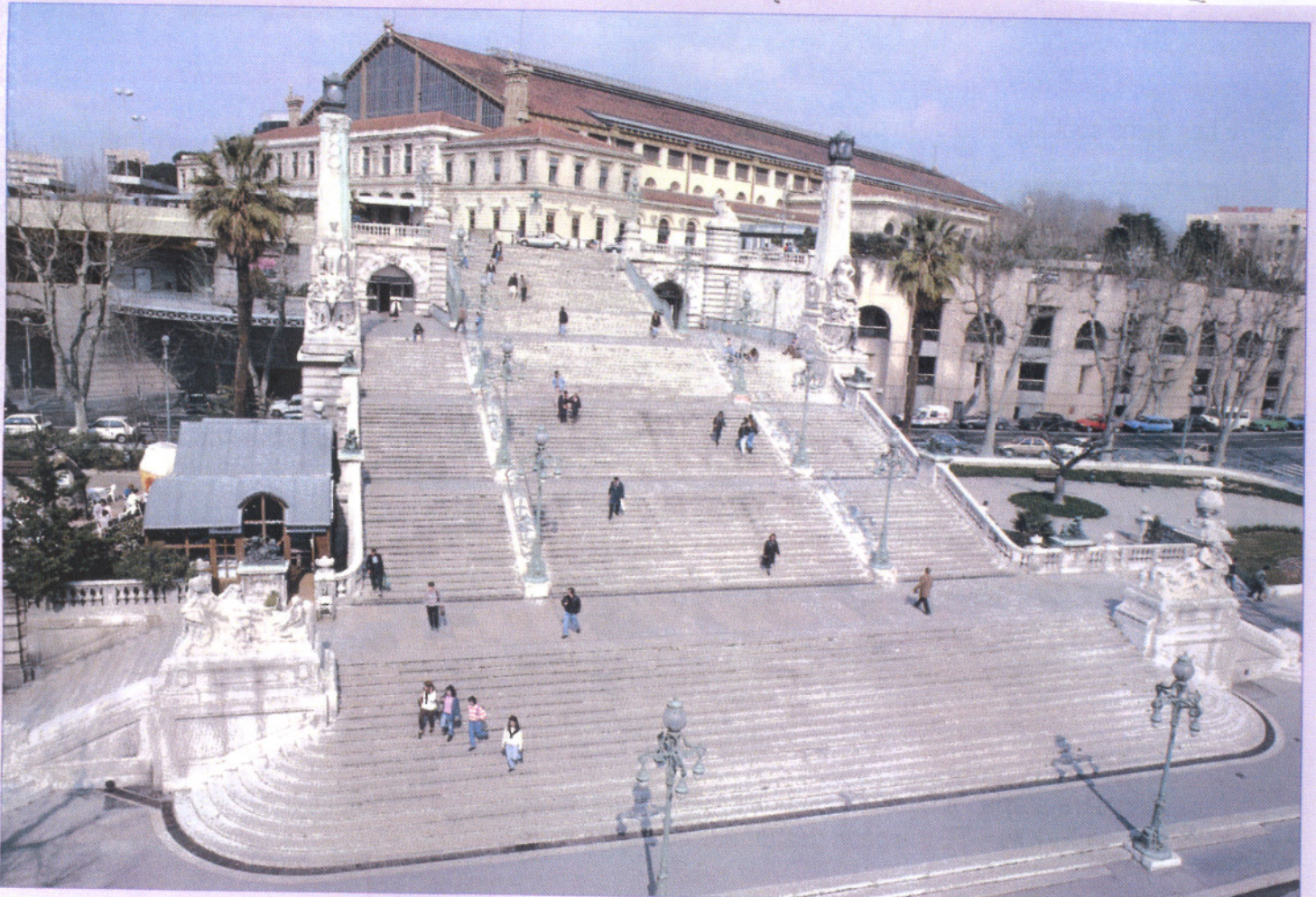
4 paliers et 104 marches sont à franchir pour accéder à la gare (photos VdR-Christophe Recoura).
