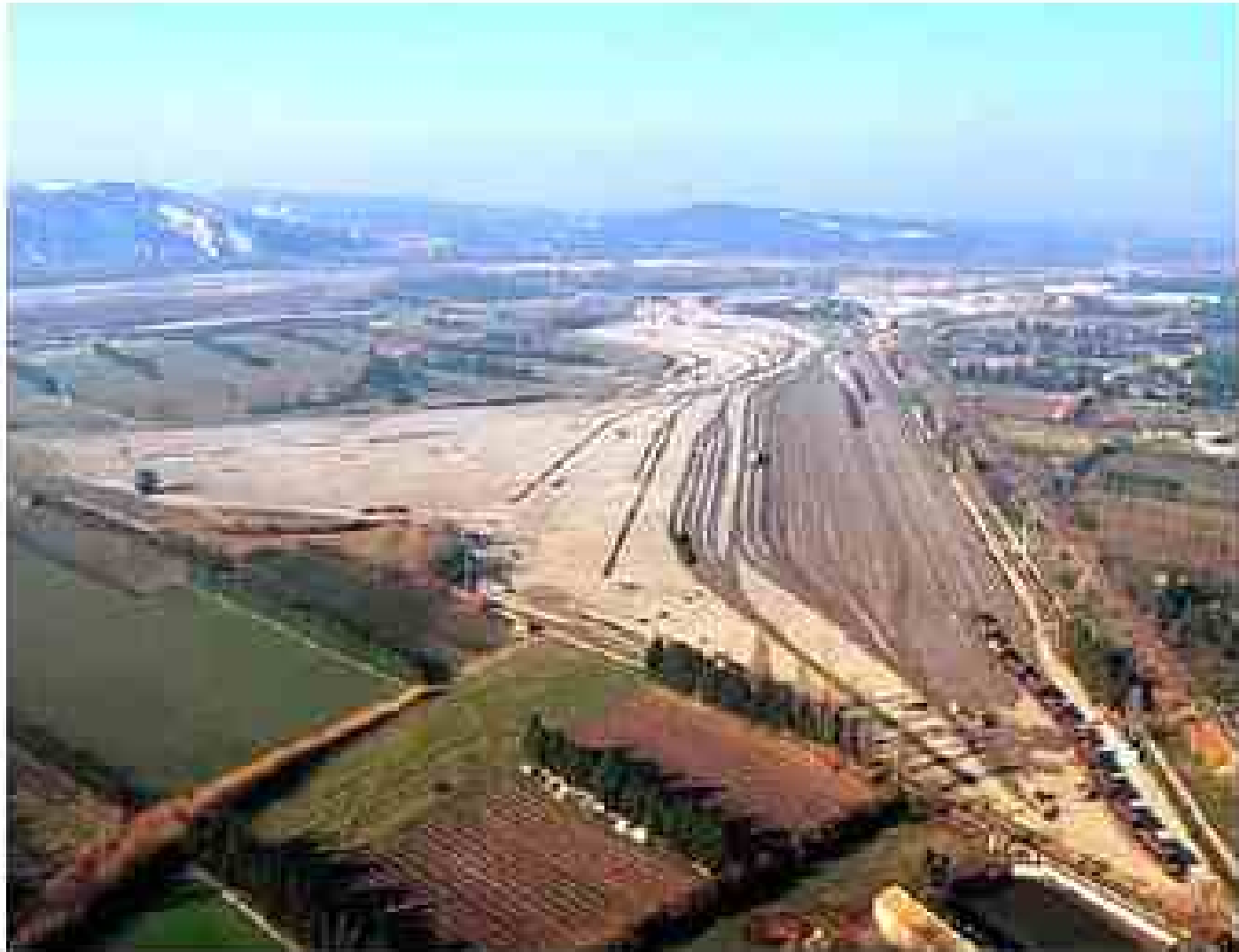
Exemple de base travaux
