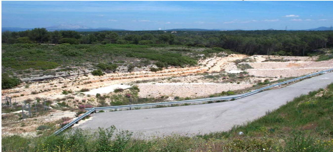
Bassin de rétention / Gare d'Aix TGV
