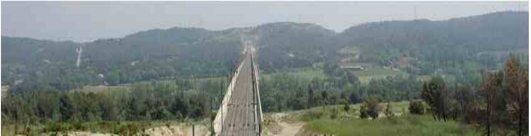
figure 63 - point de vue D - Vue depuis l'emplacement de la tranchée couverte avec la LGV
