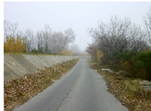
La route palière et la digue de la Durance
