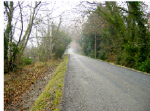
Route sur digue dans la ceinture verte
