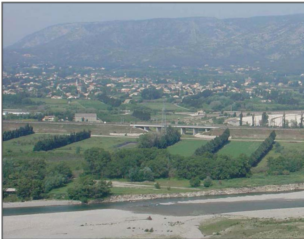
Ouvrage de décharge sur la LGV Méditerranée
