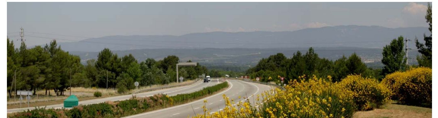
Vue de la vallée de la Durance depuis une aire de repos sur l'A51
