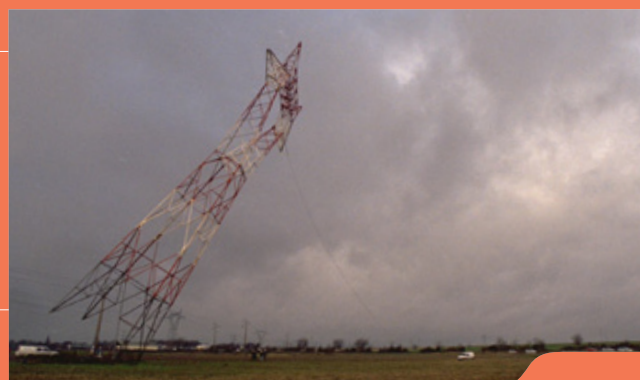
Dépose d'un pylône 400 000 volts
