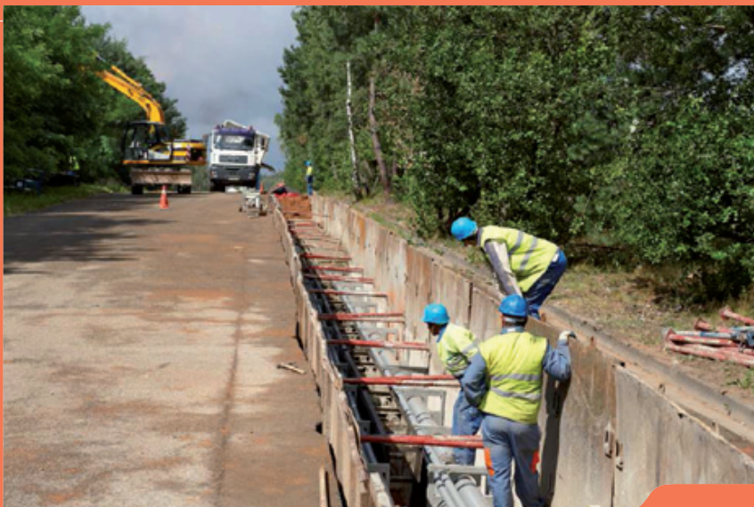
↑ Travaux de mise en souterrain
