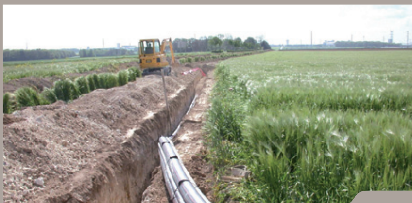
↑ Travaux de mise en souterrain
