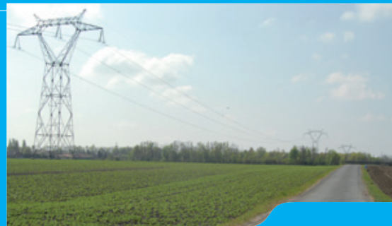
↑ La ligne 400 000 volts entre Gavrelle et Avelin
