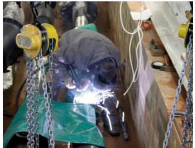
Réalisation d'une jonction : c'est une opération manuelle très délicate, réalisée dans la chambre de jonction maçonnée
