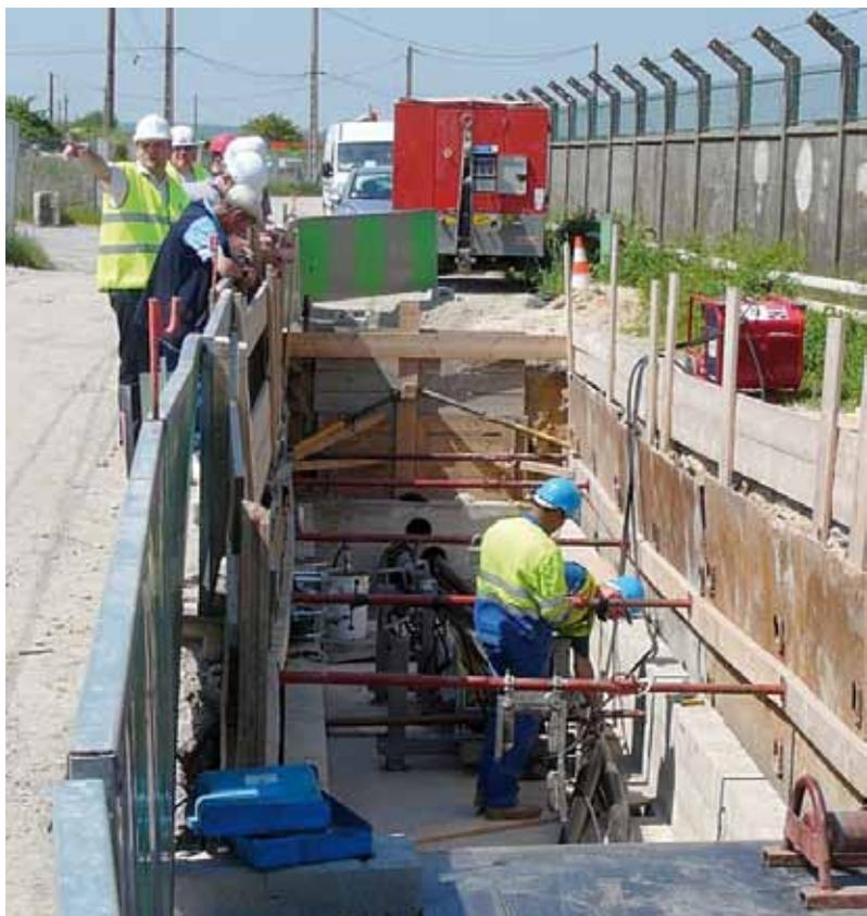
Réalisation d'une chambre de jonction (pour un tricâble)
