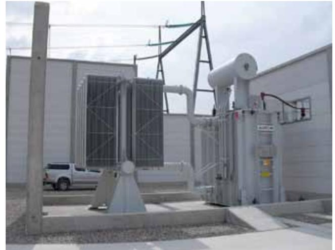
Dispositif de compensation de la capacité propre du câble
