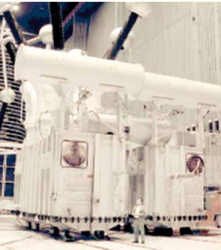
Transformateur-déphaseur installé en France à La Praz en 400 000 volts (pour un circuit)
