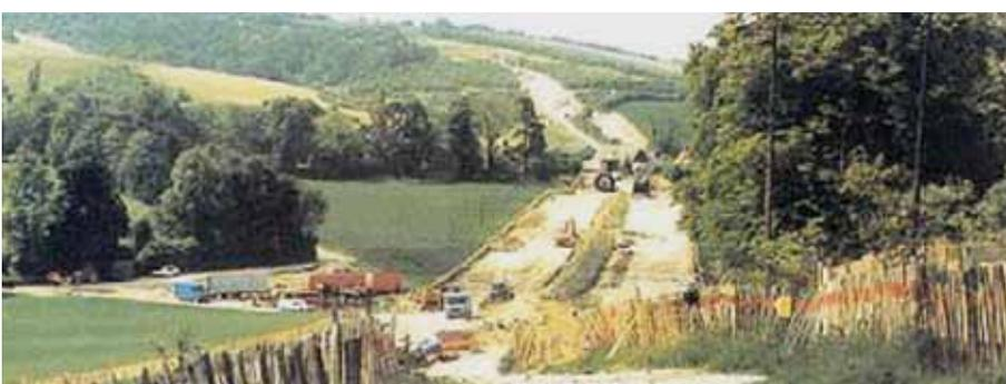
Exemple de l'impact sur les milieux d'un chantier de construction (ligne souterraine à 400 000 volts composée de quatre tricâbles, en Grande-Bretagne).
