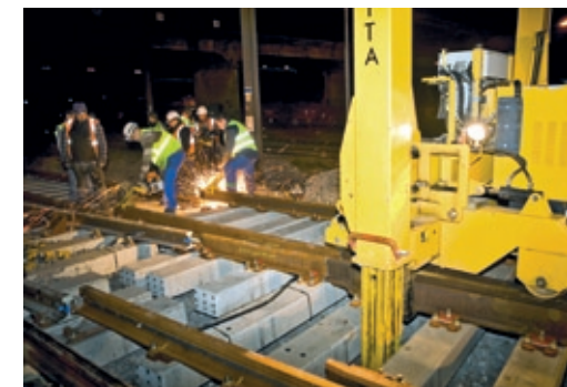
Opération de renouvellement en gare de Nîmes. Pour accroître l'usage et la qualité du réseau, sa modernisation est l'une des principales missions de RFF.
