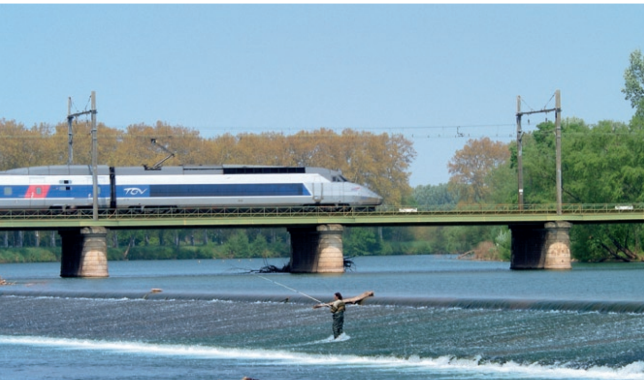
Franchissement de l'Hérault à Agde.
