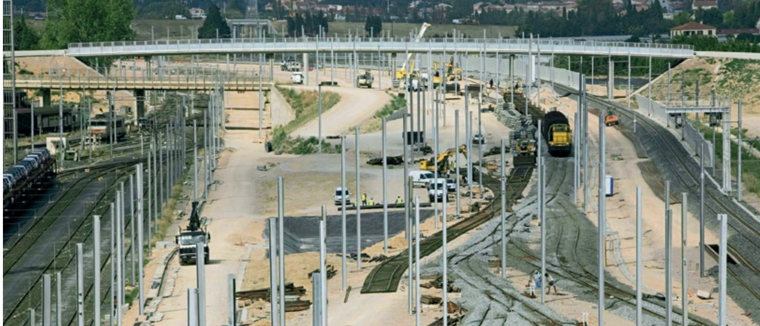
La section internationale Perpignan-Figueras, actuellement en travaux, a été réalisée en concession*.
