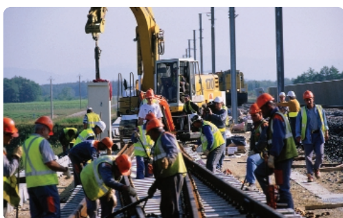
La pose des voies
