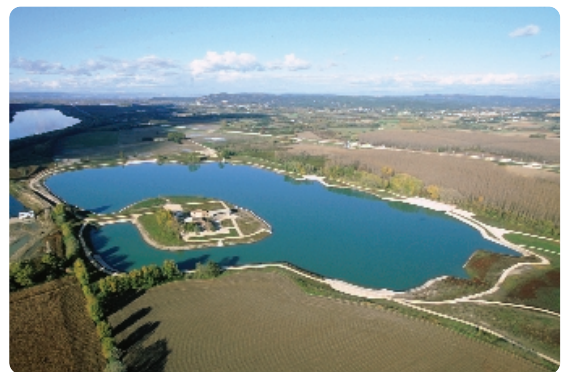
Exemple de réhabilitation d'une zone d'emprunt (LGV Méditerranée - Piolenc)
