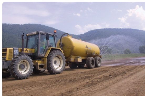
Arrosage des pistes de chantier
