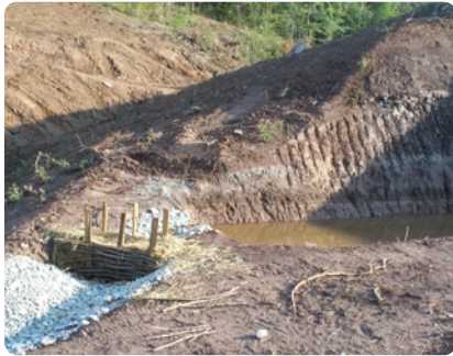
Bassin de décantation provisoire mis en place durant le chantier
