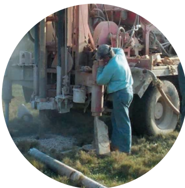
Mise en place d'un piézomètre
