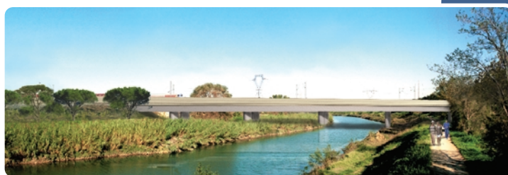
Exemple d'ouvrage de franchissement de type viaduc au niveau du Lez (photomontage)
