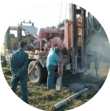
Mise en place d'un piézomètre
