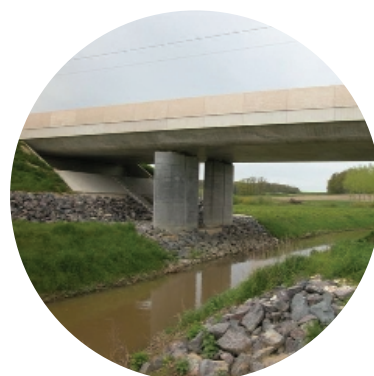
Exemple d'ouvrage aménagé pour la grande faune (passage mixte hydraulique / grande faune)
