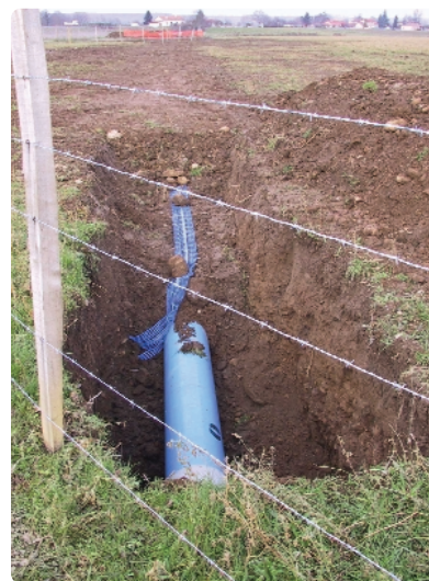
Rétablissement des réseaux d'irrigation durant les travaux
