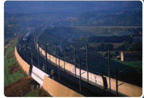
Exemple de protection à la source de type écran acoustique sur la LGV Méditerranée
