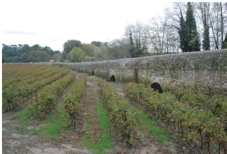
RD913. Pont de Montagnac, rive gauche de l'Hérault (unité 9)
