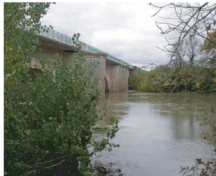
RD913. Pont de Montagnac sur l'Hérault (unité 9)
