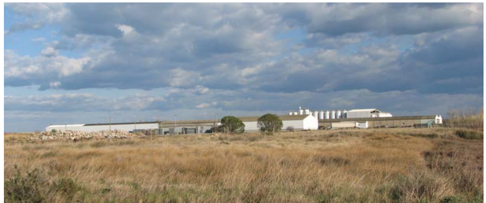
Entreprise Listel sur le lido de l'étang de Thau (photo Egis)
