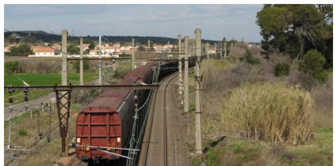
Circulation sur la ligne existante entre Montpellier et Sète (Photo Egis)
