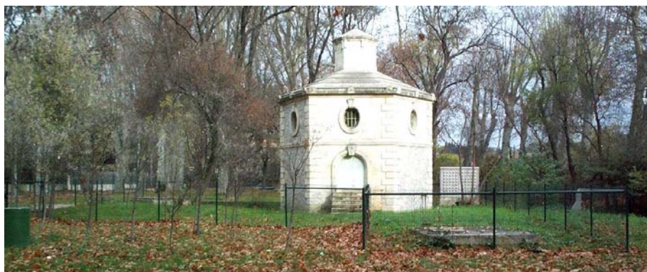
Captage d'alimentation en eau potable d'Issanka (Photo Egis)
