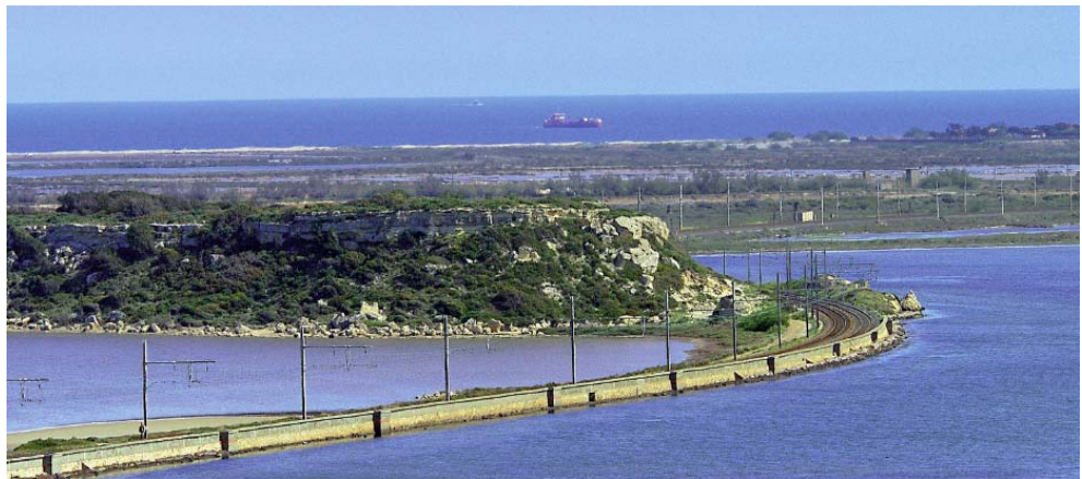
Traversée de l'étang de Bages - Sigean par la ligne classique
