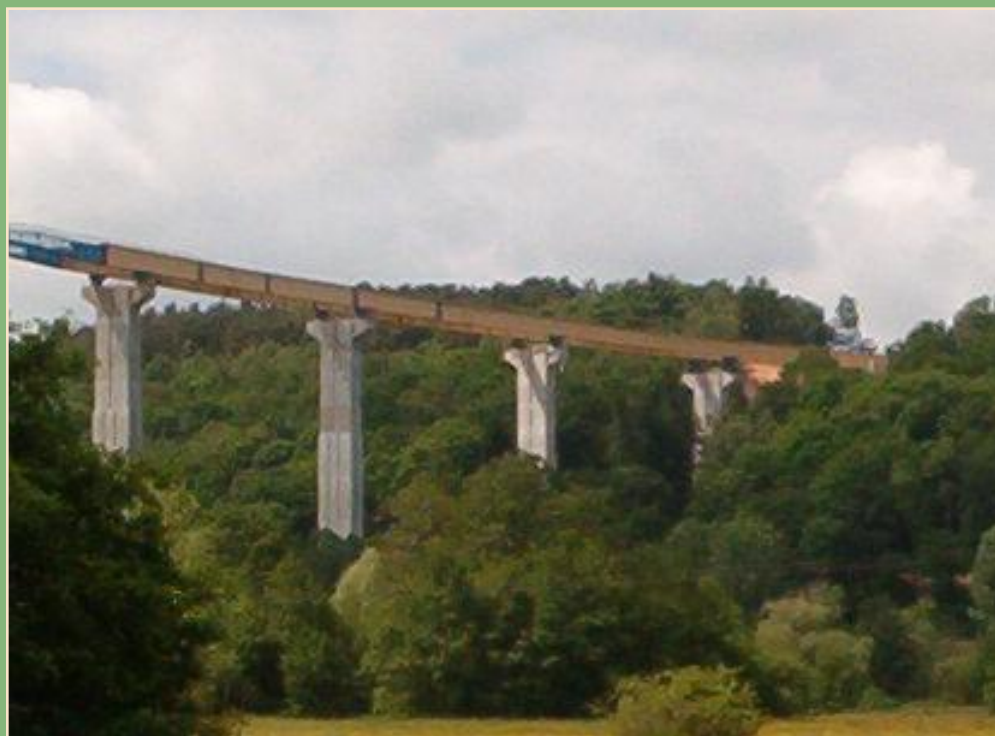
Franchissement de la vallée de la Risle
