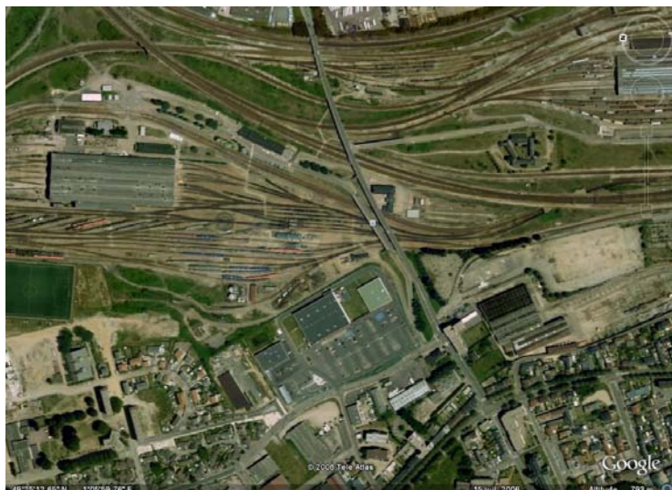
Vue partie Nord pont d'Eauplet
