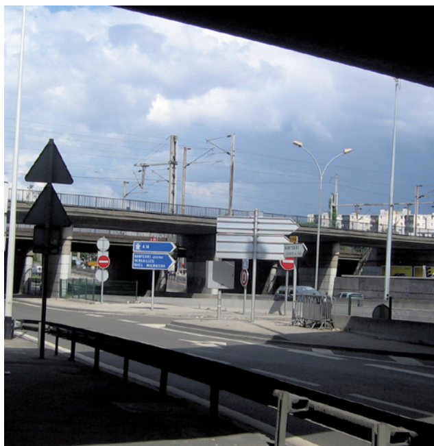
Nanterre « Pont de Rouen ». RFF veut faire passer EOLE ici (sans s'y arrêter) en superviaduc à côté du tunnel de la LNPN... d'où des nuisances supplémentaires sans contrepartie pour les riverains.
