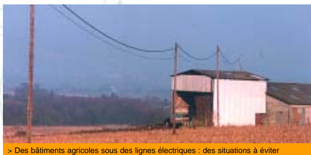
> Des bâtiments agricoles sous des lignes électriques : des situations à éviter
