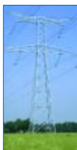
Pylône 400 000 volts à 2 circuits de type F5 (à gauche)
