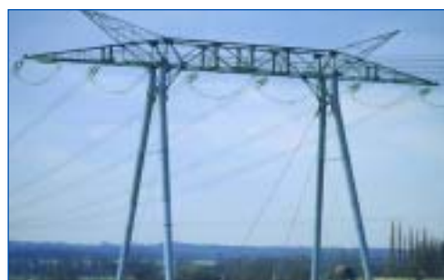
Pylône 400 000 volts à 2 circuits de type Trianon
