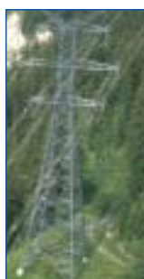
Pylône 400 000 volts à 2 circuits de type F5 (à gauche)
