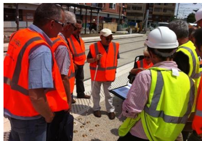
Choix du dispositif de repérage sur les quais des portes doubles accessibles du tram - 2013
