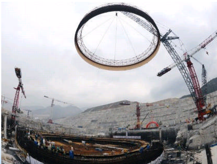
Installation de la charpente métallique à Taishan en Chine (Image: CGNPC, )
