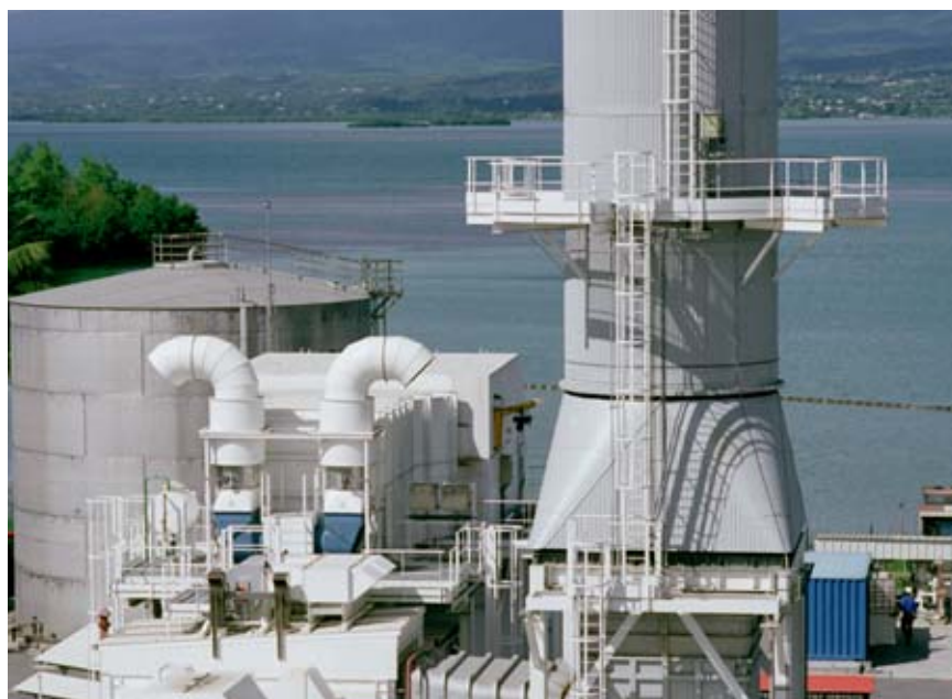
Centrale géothermique de Bouillante (Guadeloupe).
