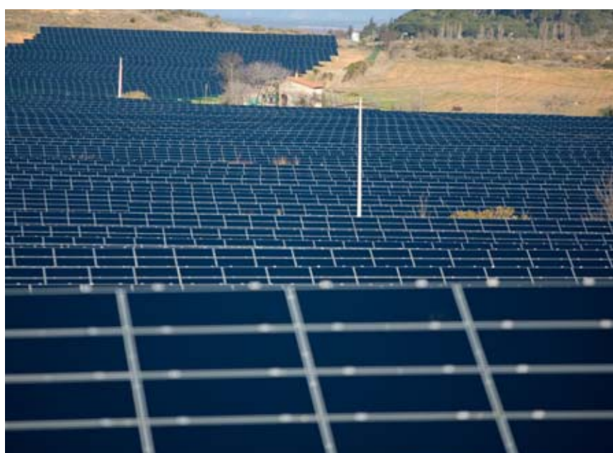
Ferme solaire de Narbonne (Aude).
