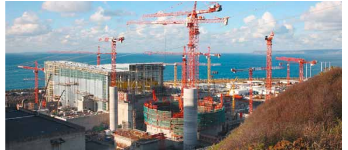
Construction du premier réacteur EPR en France, à Flamanville.
