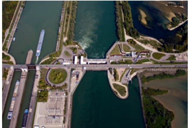
Centrale hydraulique de Gamsheim.
