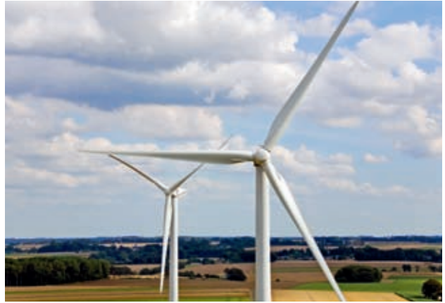
Parc éolien de Veulettes-sur-mer.
