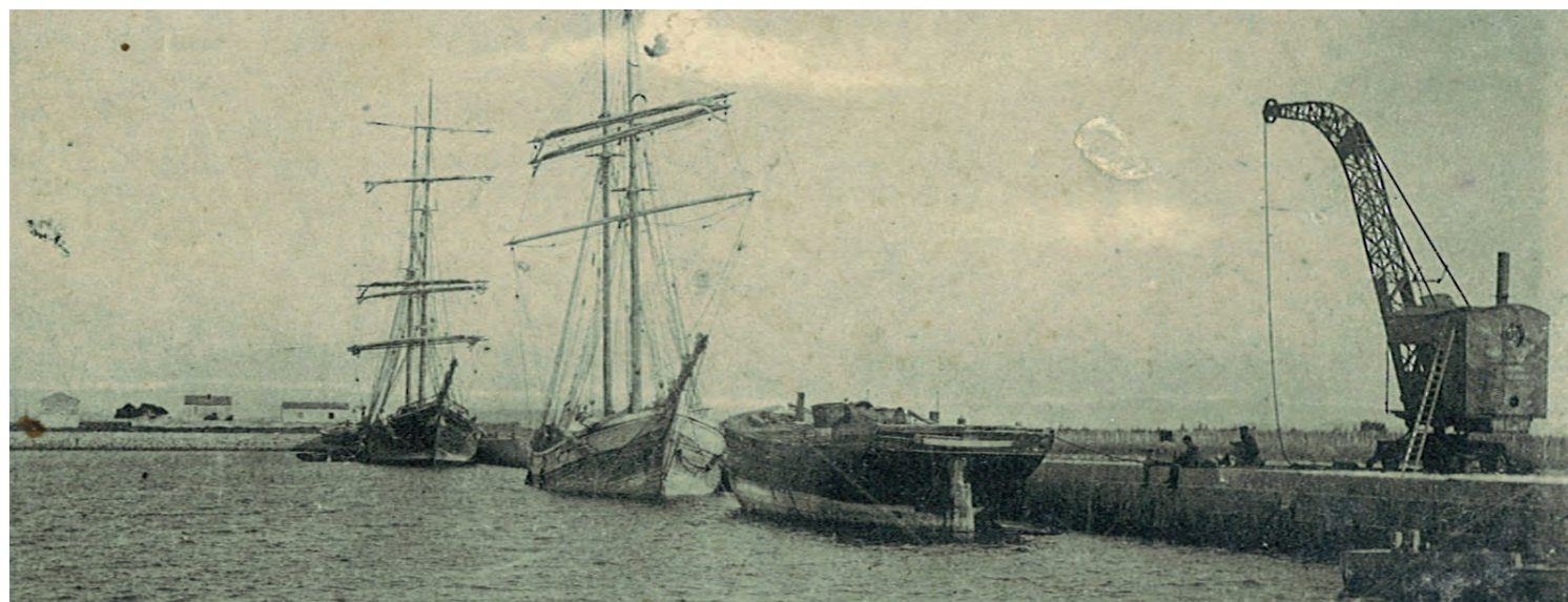
1917, mise en place d'une grue de 3 tonnes
