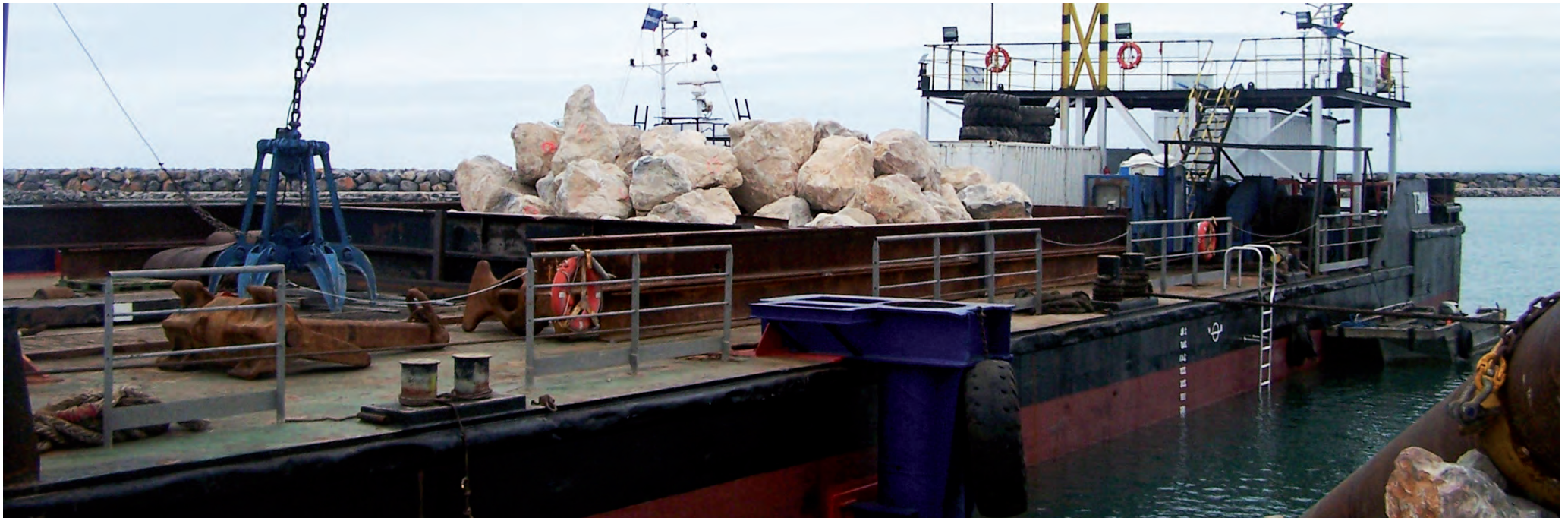
Port-La Nouvelle, travaux de confortement de la digue Sud
