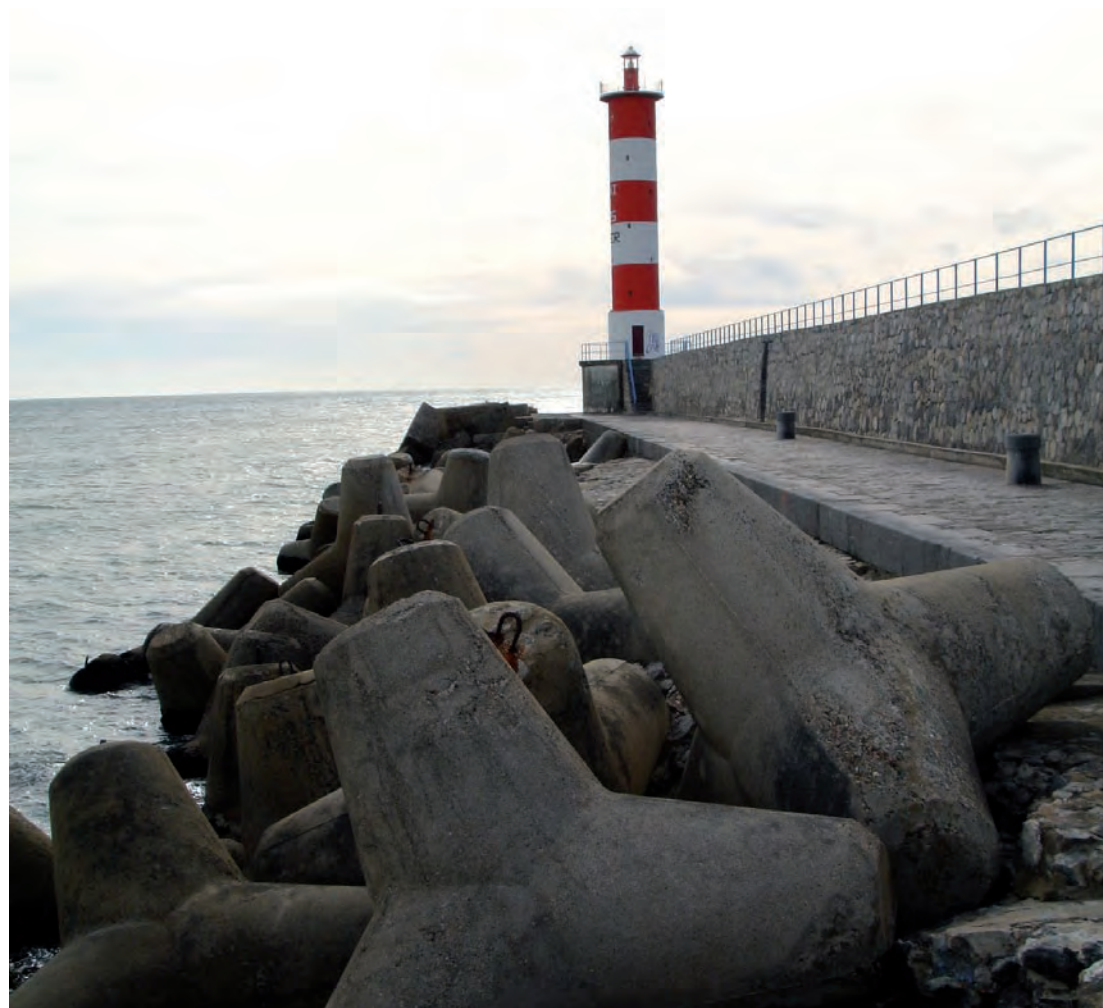
Port-La Nouvelle, digue Sud
