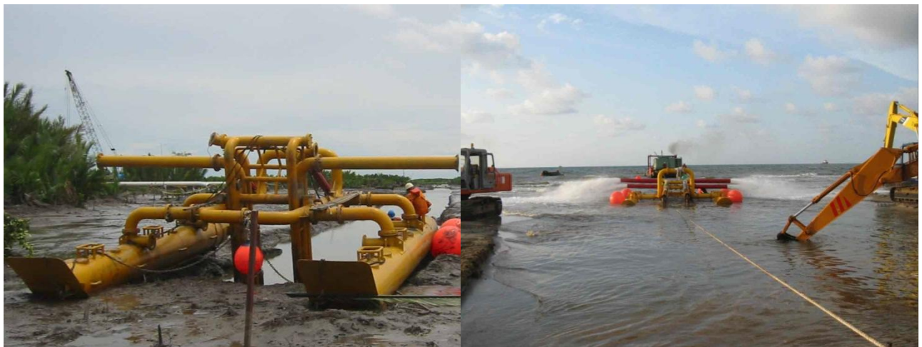
Photo 2 : Exemple de moyens d'ensouillage : trancher utilisant de l'eau sous-pressure
