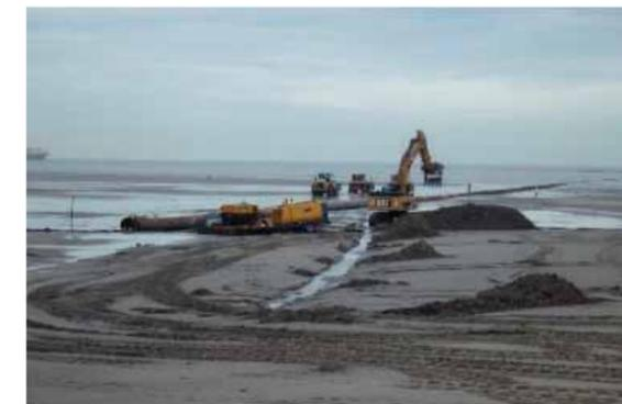
▲ FIGURE 77 Drague stationnaire avec évacuation des sédiments par canalisation
