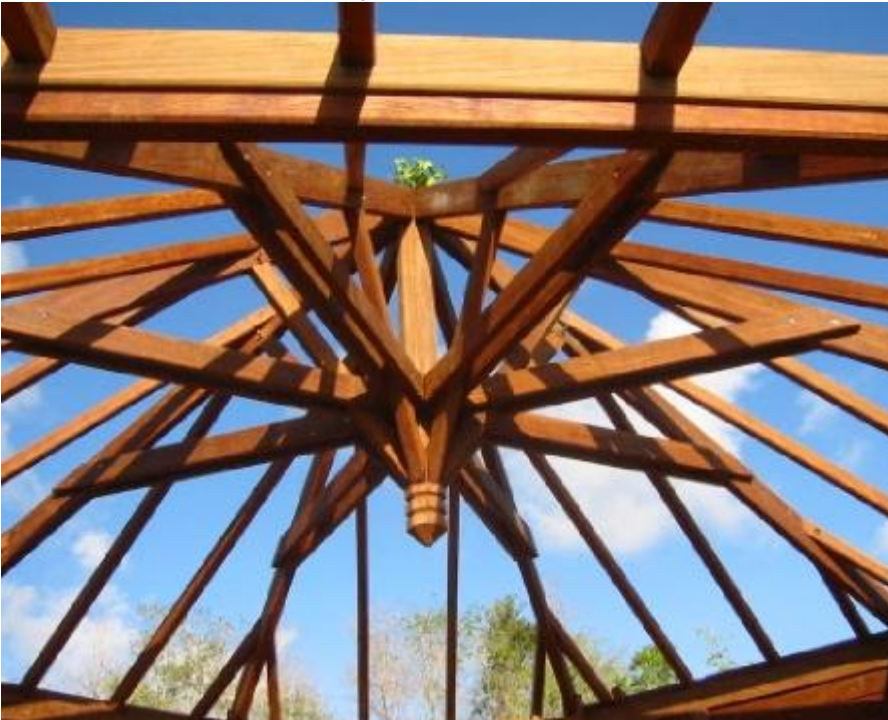
Charpente de maison
