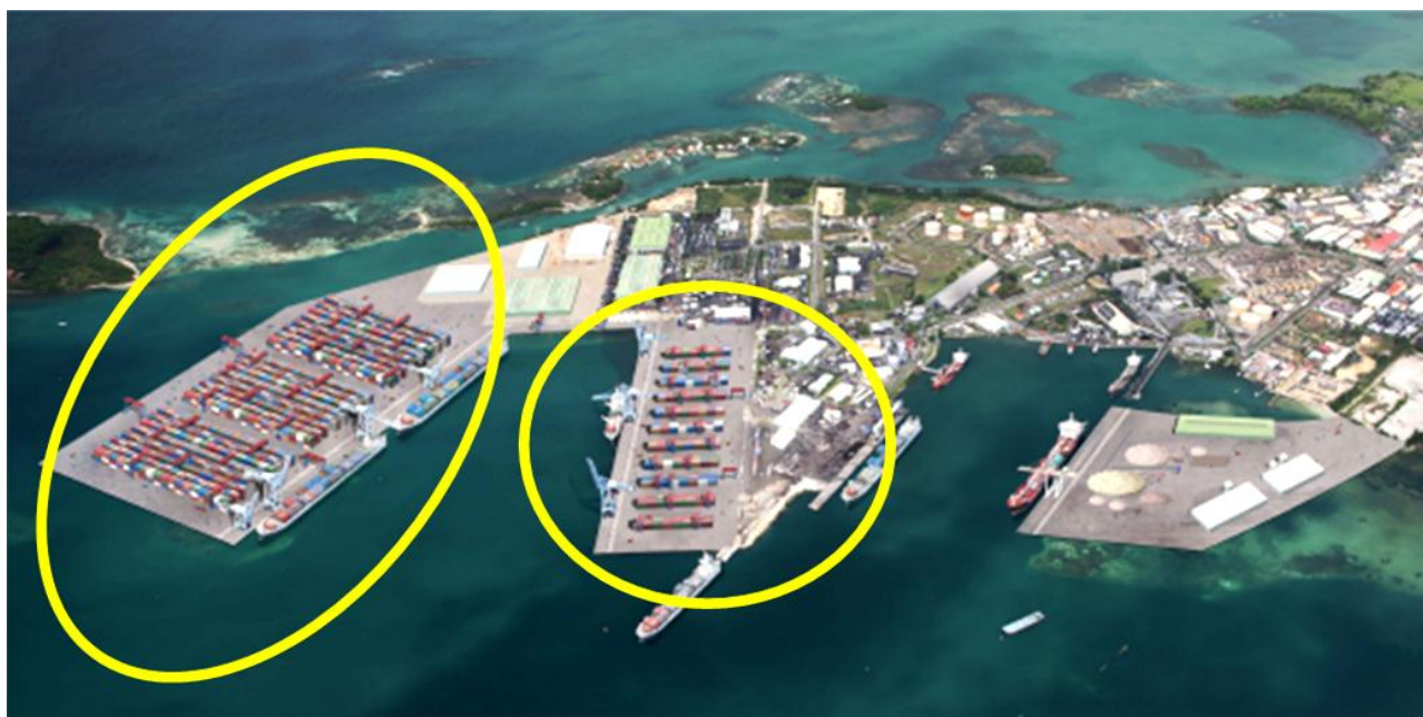
FIGURE 1: LE NOUVEAU TERMINAL A GAUCHE DU TERMINAL ACTUEL, SOURCE PAG
