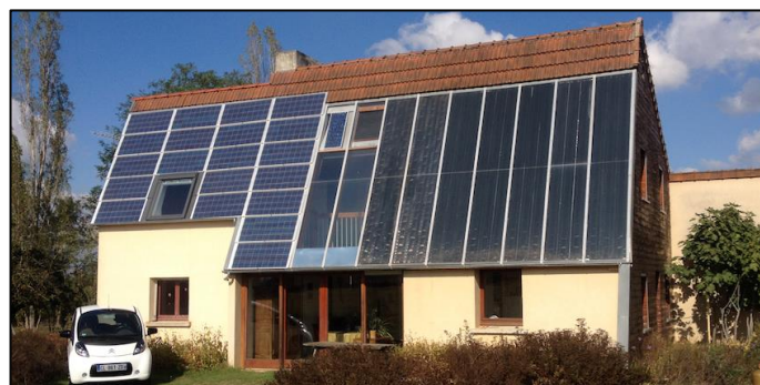
20 m 2 de photovoltaïque pour alimenter la voiture électrique et la maison, et 20 m 2 de solaire thermique pour chauffer la maison.
