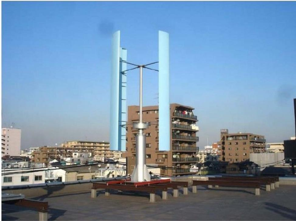
Eolienne type Darrieus hauteur 3,60m diamètre 2,40m
