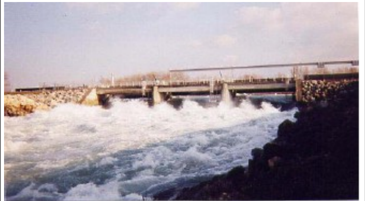
Le déversoir de Mallemort qui ouvre le canal EDF sur la Durance
